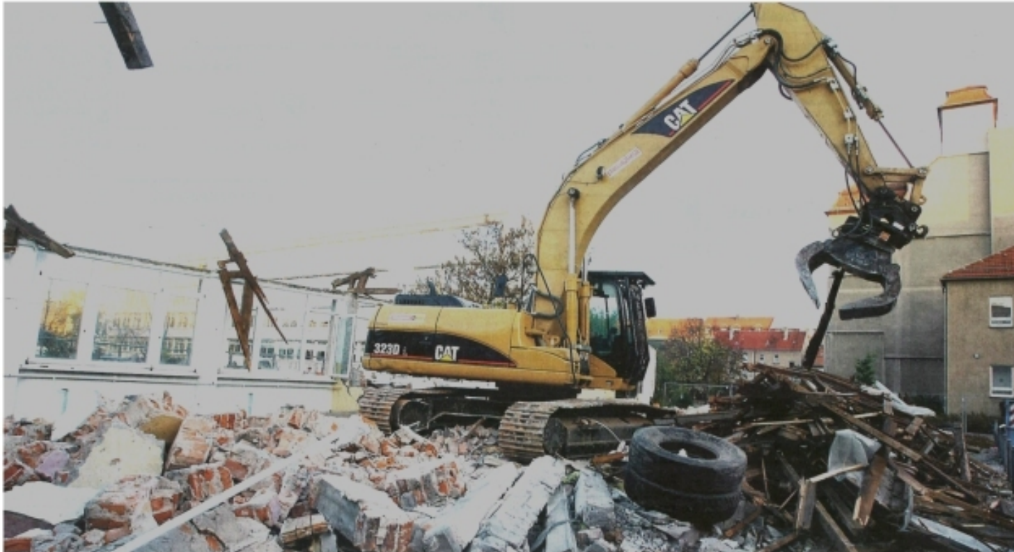
Bagger schafft Baufreiheit: Spätestens Mitte nächster Woche wird von der Hortbaracke der Mittelschule Markkleeberg nichts mehr übrig sein. Im Frühjahr 2009 soll auch der zweigeschossige Sanitärtrakt (rechts) der Abrissbirne zum Opfer fallen. Foto: André Kempner
