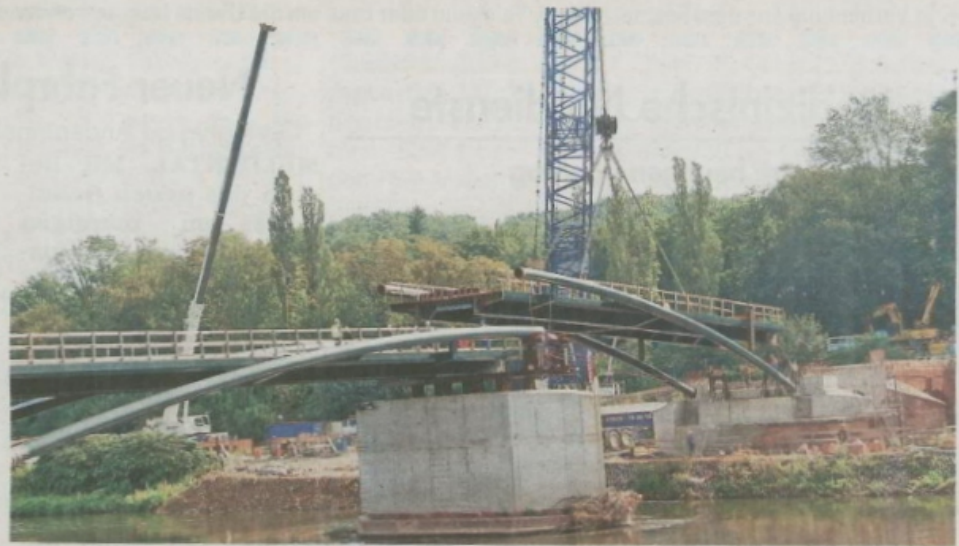
Brückenschlag: Am Mittwoch wurde das zweite Sprengwerkteil an der Pöppelmannbrücke montiert. Fotos: Roger Dietze
