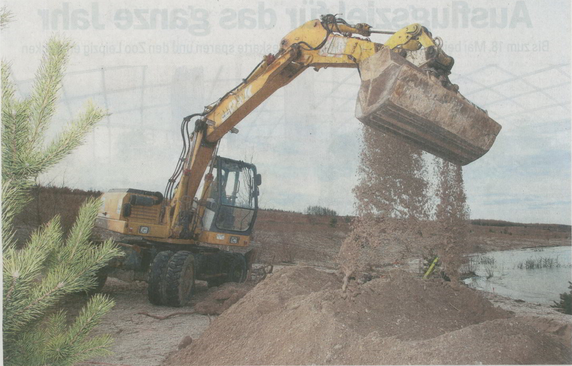
Die ersten Baggerarbeiten für den neuen Schiffsanleger am Störmthaler See in Großpösna beginnen. An der Ostspitze des Sees werden künftig nicht nur Ausflugsboote anlegen können, hier wird die Feuerwehr auch zu ihren Seerettungseinsätzen starten. Foto: Andre Kempner
